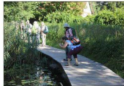
Malgré les travaux en cours, une partie du sentier des mares reste accessible aux visiteurs. Photo l'Alsace
