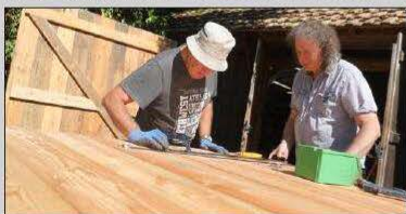
Ces dernières semaines, les bénévoles ont refait à neuf la double porte de l'un des abris à foin. Photo l'Alsace
