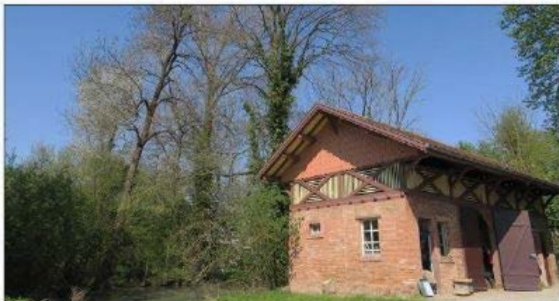
La charlarose du frêne est un sujet préoccupant dans la Petite Camargue alsacienne, pour des questions de sécurité, en particulier. Ici, au cœur du domaine, ce bosquet de frênes commence à menacer les dépendances de la réserve naturelle. Photos DNA/J.F.O.
