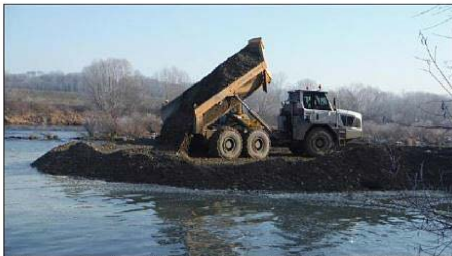
Plusieurs recharges sédimentaires ont été effectuées ces dernières années à la Petite Camargue alsacienne. 20 000 m 3 par ici, 60 000 par là. Mais pour que le transport sédimentaire se refasse, il faudra encore des dizaines d'années d'actions. DR
